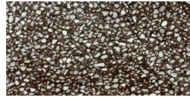
Wände EG, Podeste und Treppen Carrara Rosa
